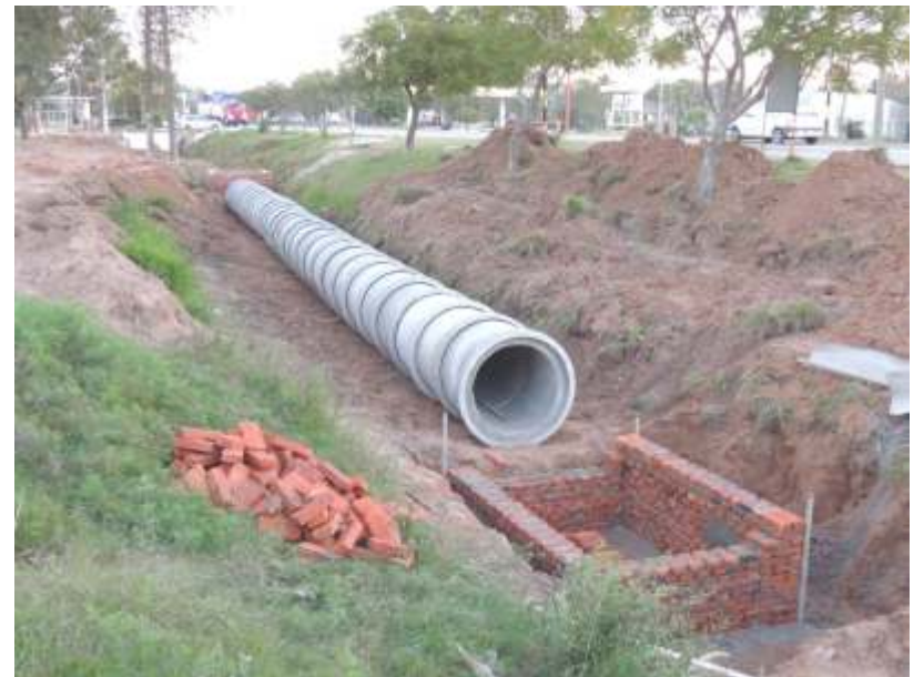
Colocación de tubos y construcción de cámaras en la cuneta este de ruta provincial Nº 1.
