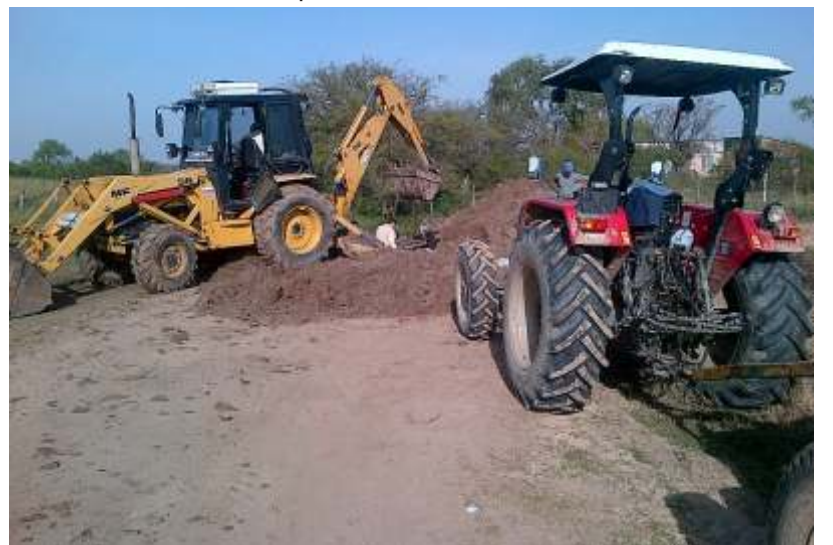
Máquinas realizando nuevo entubado en Colonia Oeste.
